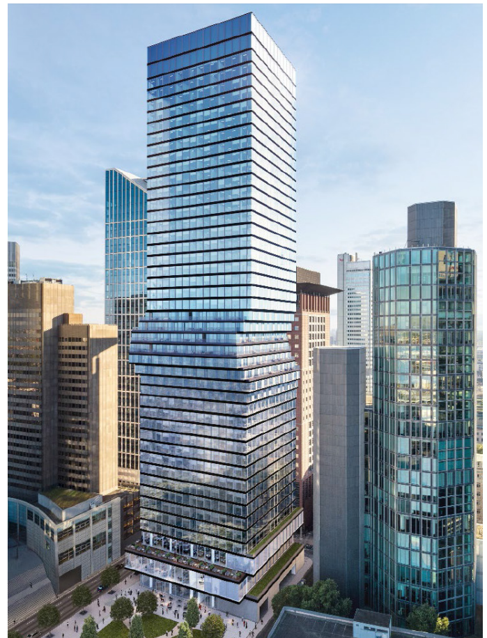
Abb. 2: Omniturm, Frankfurt (©Stahlwerk Annahütte)
