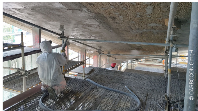
Abb. 2, 3: Sanierung und Verstärkung der Hyparschale
