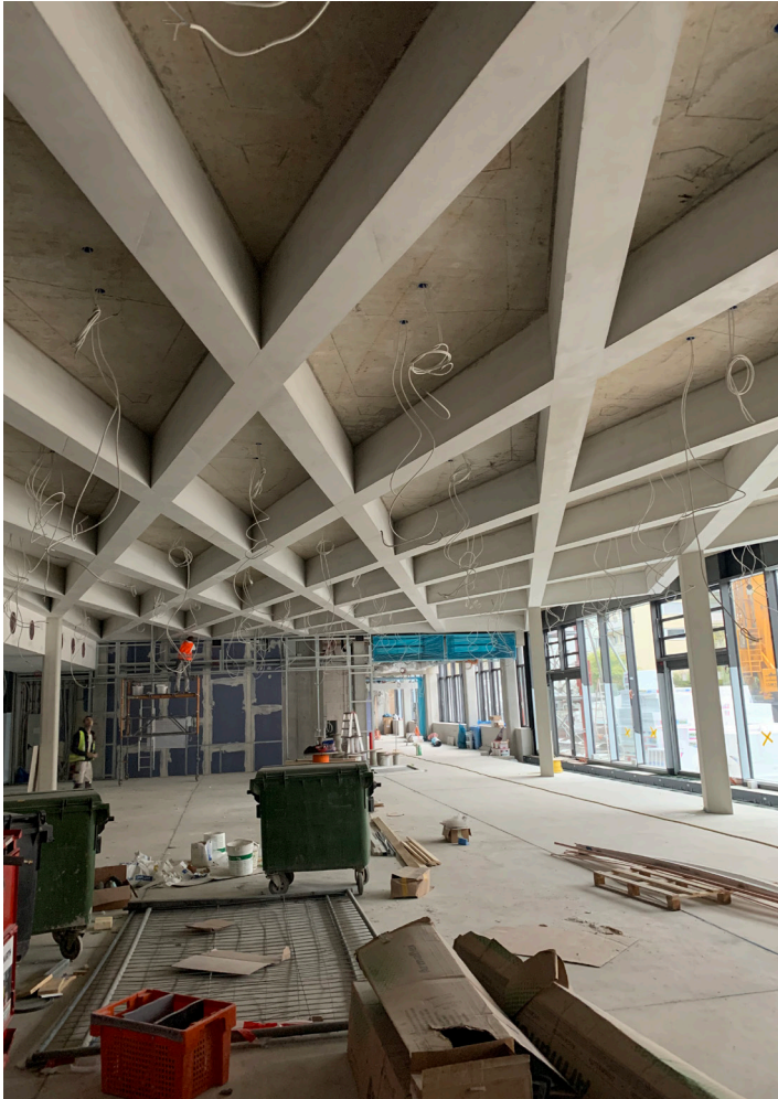
Die Casinodecke mit fächerartigen Unterzügen. (©Wulle Lichti Walz)
