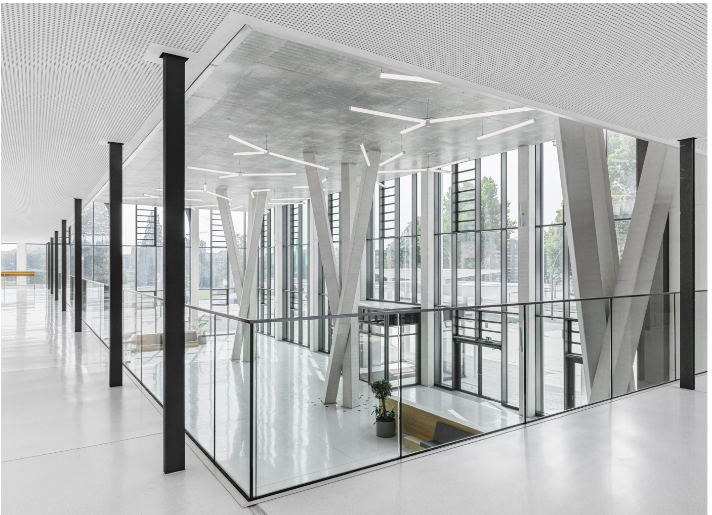
Drei elf Meter hohe Baumstützen zieren das großzügige Foyer. (©Thilo Ross)
